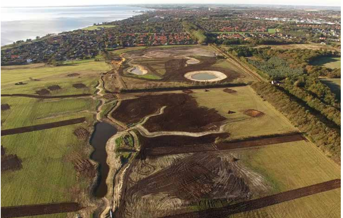
I 2015-16 omdanner Ringkøbing K det tidligere landbrugsareal til et rekreativt naturområde, før husene i bydelen kan bygges. Samtidig med udviklingen af naturen bliver hele bydelen klimatilpasset. Luftfoto fra anlægsarbejdet, oktober 2015.
