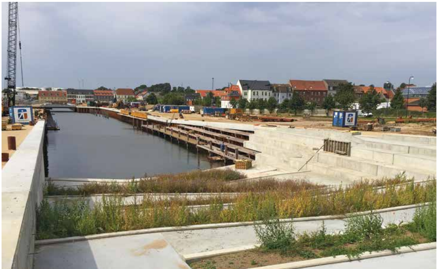
Promenaderne langs kanalerne i FredericiaC hæves til 2,5 meter over dagligt vande. Jord fra udgravningen af kanalerne bruges til terrænhævningen.
